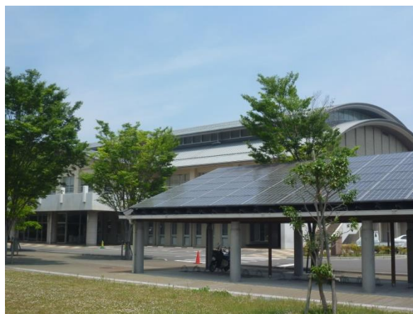
中津市総合体育館の太陽光発電
