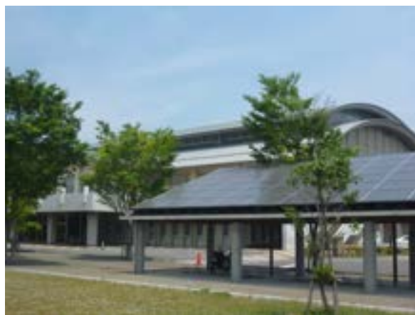
中津市総合体育館の太陽光発電
