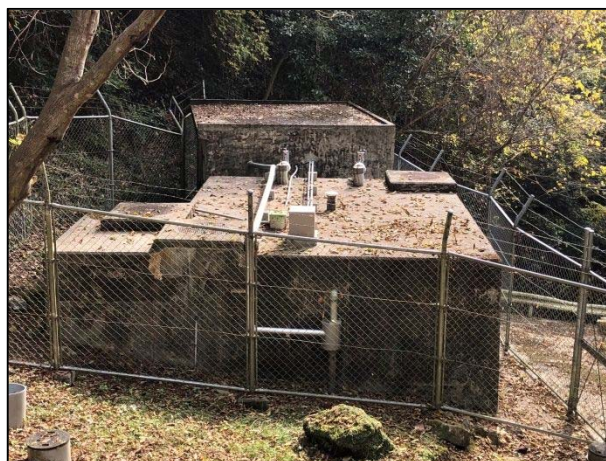
上曽木配水池
