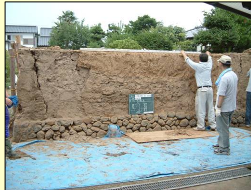
既存土塀の解体
