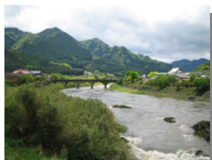
河川景観(平田地区馬溪橋下流) 広がりや連続性を感じさせる景観
