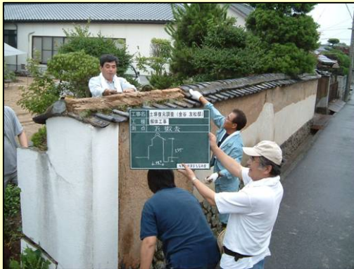
解体前の土塀の調査
