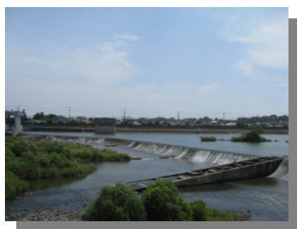
河川景観(三口の大井手井堰) 人の営為が反映された景観
