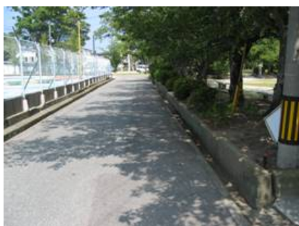
道路事業(二の丸公園地線) 整備前
