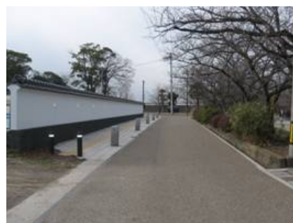
道路事業(二の丸公園地線) 整備後
