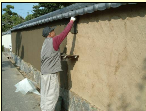
土塀の壁面塗装作業
