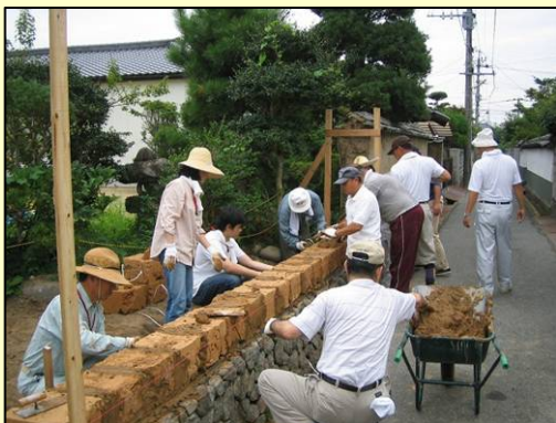
土ブロックの積上げ作業
