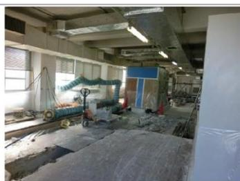
現場調査時の施工中の電気室。既設盤を撤去している。奥側に「16007 中津 T\_3\_5 系水処理設備 1次盤/予備(HT26)」があるが、工事の邪魔とならうよう近付いていない。
