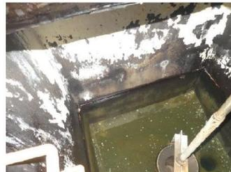
11090 中津 T\_第1汚泥消化タンク\_付帯設備\_内部防食
