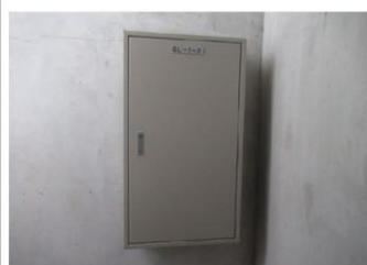
14081\_中津 T\_汚泥消化タンク機械室\_電気設備\_電灯分電盤
