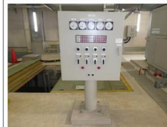
46031 米山雨水 P\_No.1\_2 雨水ポンプ 現場操作盤(LCB-B1)
