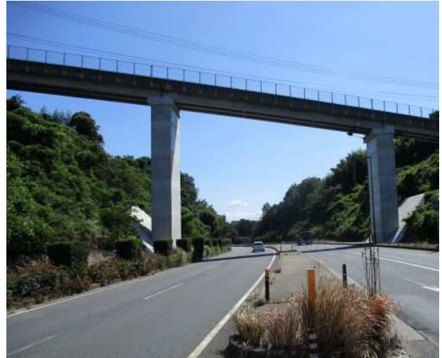
小平跨道橋 橋りょう長寿命化事業
