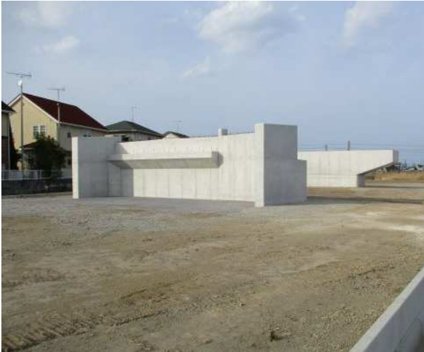
下池永西大新田線 道路改良事業 (建設中)
