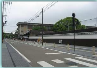
南部小学校の白壁設置
