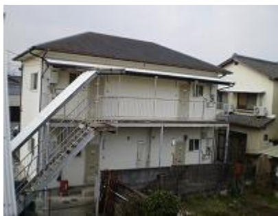
②メゾン寺町C棟
