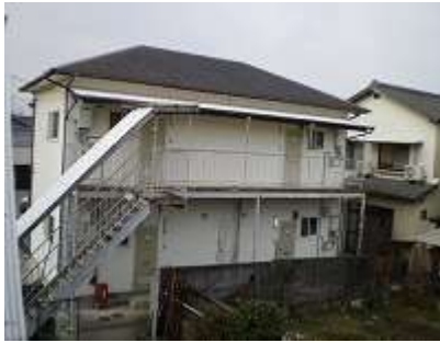
②メゾン寺町C棟
