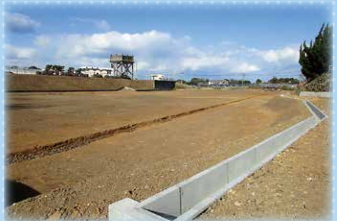
配水池増築現場
