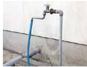
屋外にむき出しの水道管
