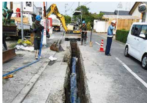
老朽化した管の取替状況
