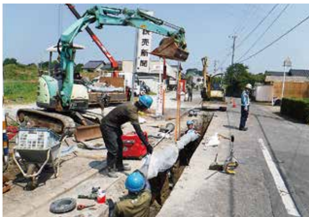
老朽化した管の取替状況
