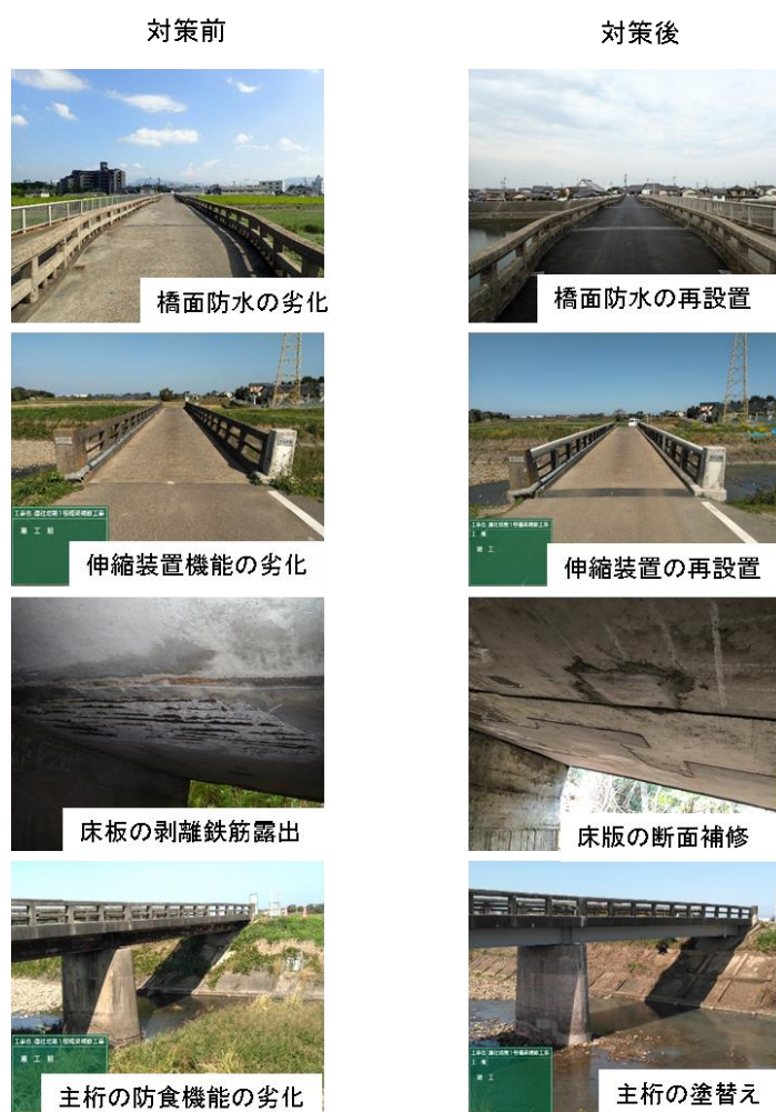
図-6 橋梁補修対策の事例写真
