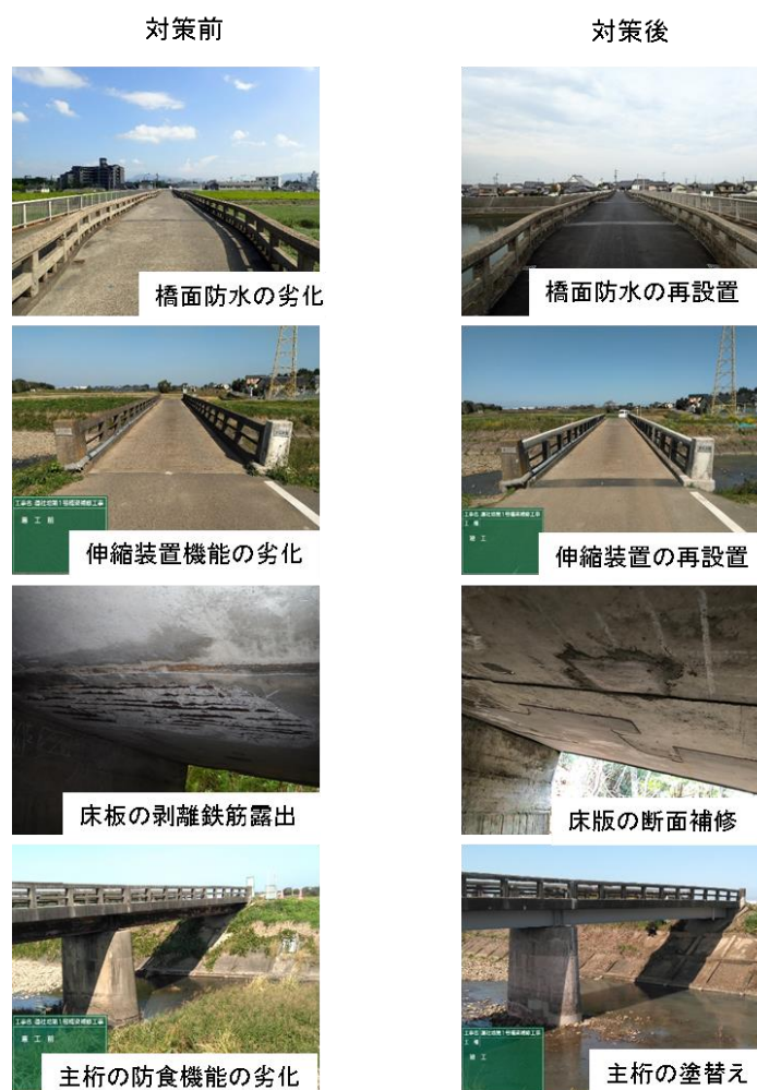
図-6 橋梁補修対策の事例写真
