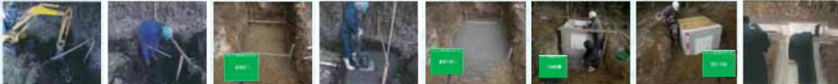
①床掘 ②基面整正 ③床掘完了 ④基礎碎石
