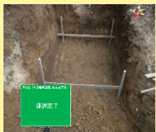
③床掘完了
