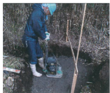
④基礎碎石 転圧状況
