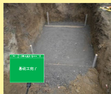
⑤基礎工完了
