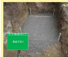
⑤基礎工完了
