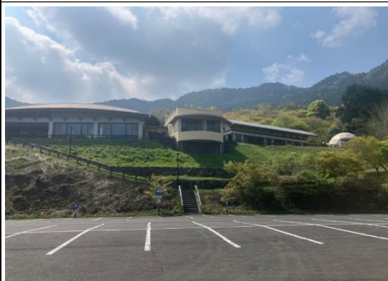
八面山荘全体の外観
