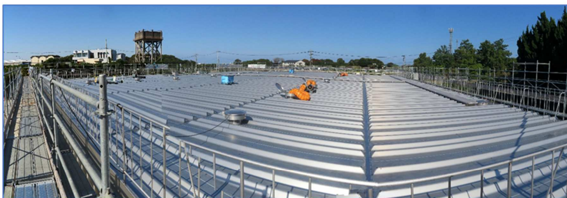
屋根部全景（足場上より）（パノラマのため写真にゆがみ有り）
