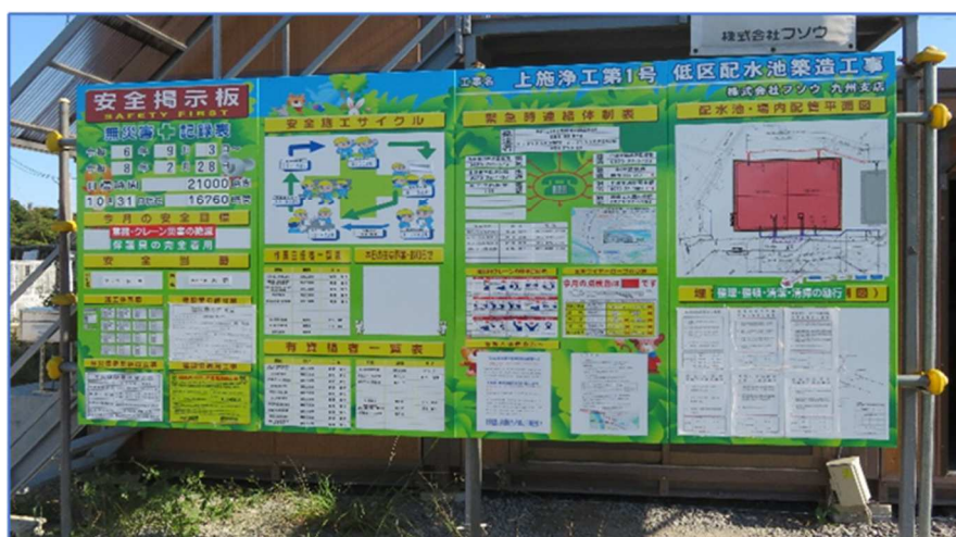
現場掲示物（建設業の許可票、労災保険関係成立票、施工体系図など、建設業法、同・施行規則等により定められた掲示物は全て正しく掲示されている）
