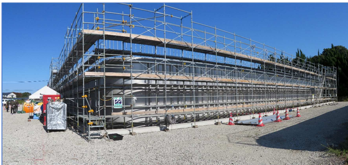
新設低区配水池全景
