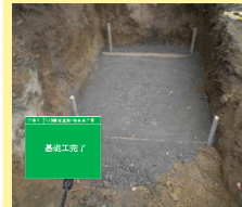
⑤基礎工完了
