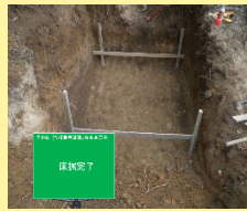
③床掘完了
