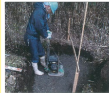
④基礎砕石 転圧状況
