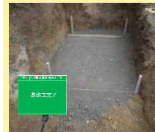
⑤基礎工完了
