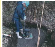
④基礎碎石 転圧状況
