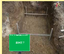
③床掘完了
