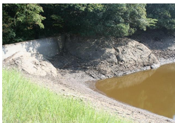
上深水・下深水地区ため池
