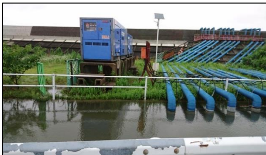
浸水時の仮設ポンプの状況
