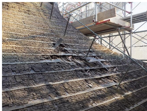
葺き替え前の腐朽した屋根
