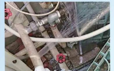
古い保温材の隙間から破裂した給湯器配管
