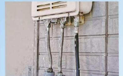
水抜きを忘れて破裂した給湯器
