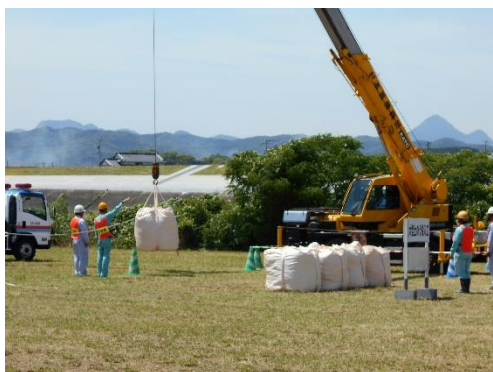
大型土のう投入工
