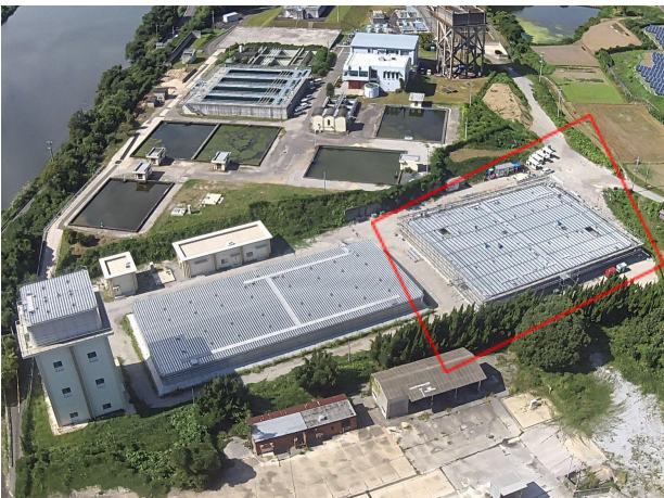
三口浄水場の工事の進捗状況 (□は令和7年度末に完成予定の新配水池)
